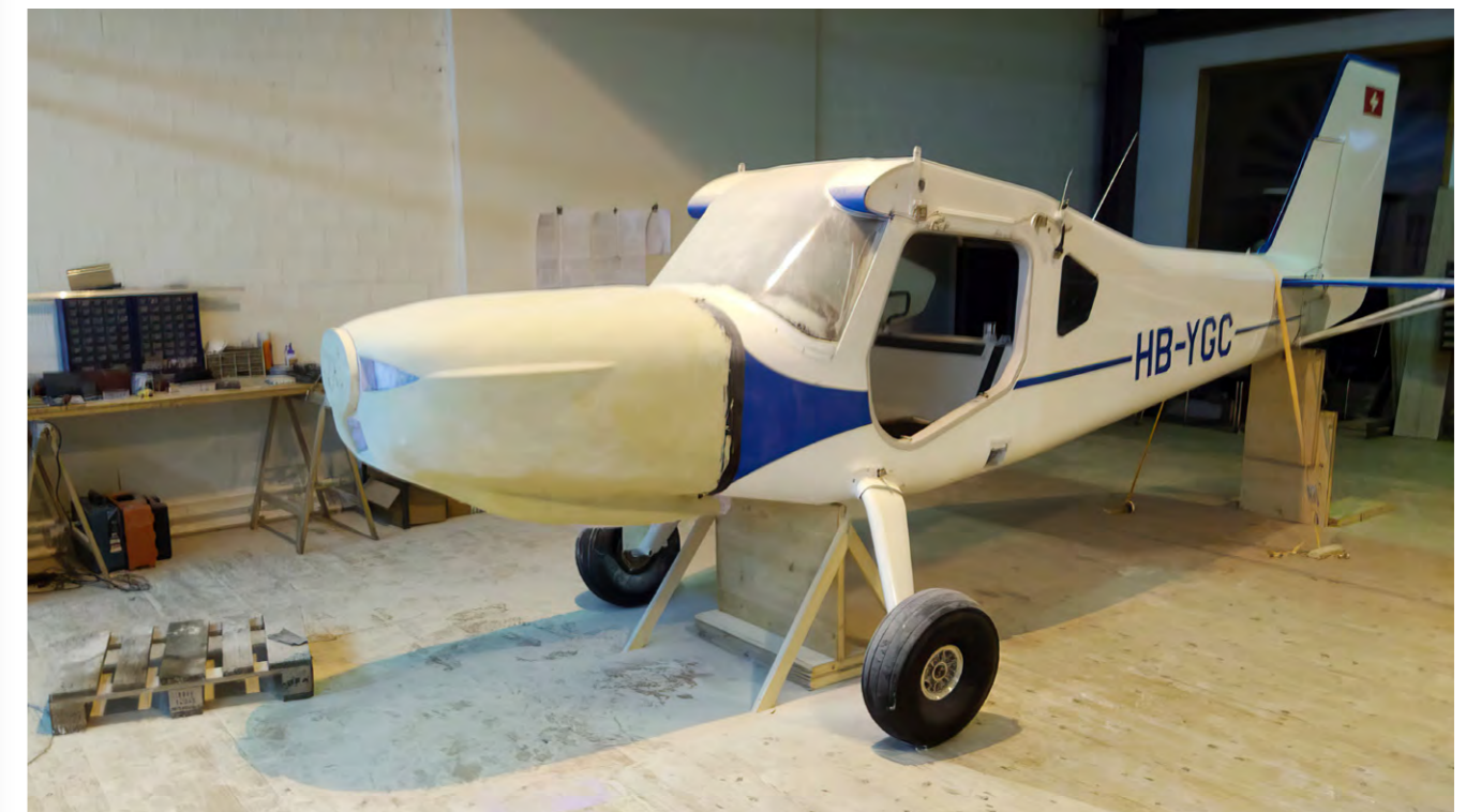
Haubenrohling gespachtelt und geschliffen – bereit zum Abformen – Ébauche de coiffe mastiquée et poncée – prête à être moulée
