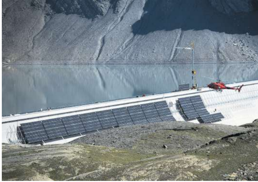
Gut ein Drittel der Solarmodule ist mittlerweile installiert.
